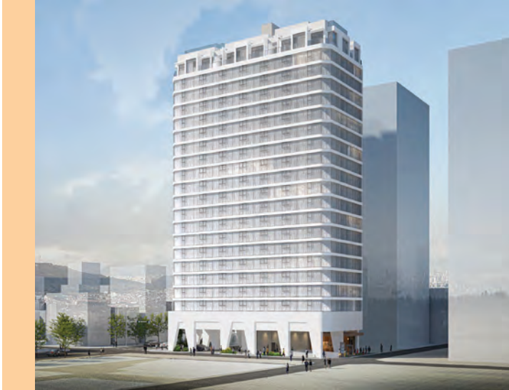
부산 수영구 광안동 199-7 도시형생활주택 신축공사
