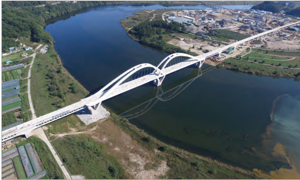
중앙선도담~영천 복선전철 토공 및 구조물공사 (2014.06~2021.08)
