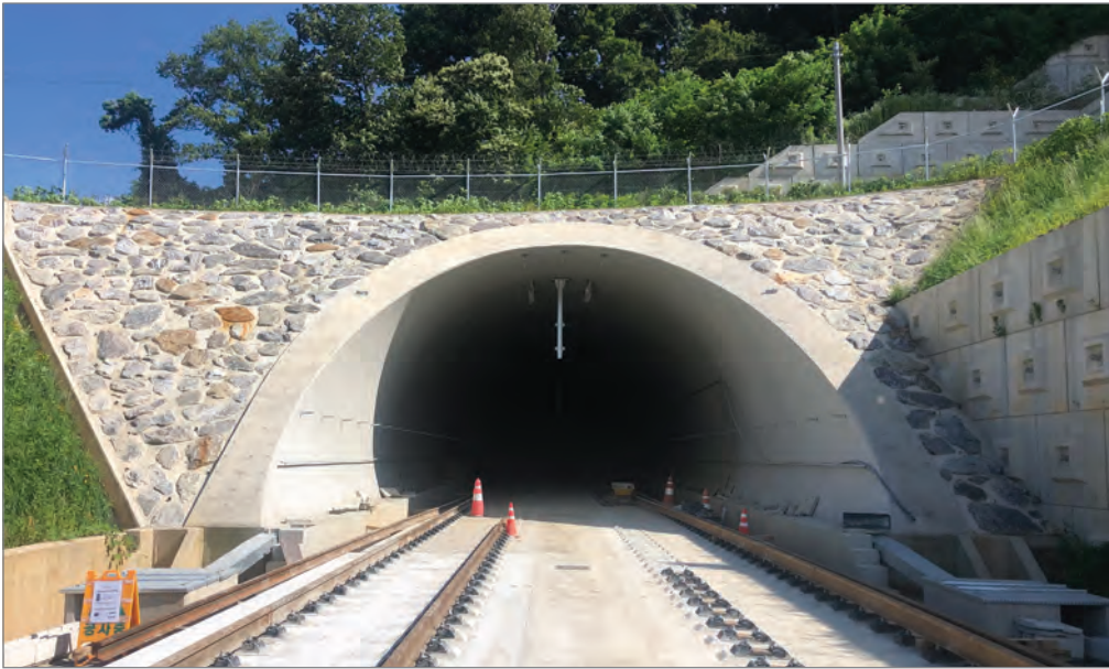
서해선 흥성~송산 전철 8공구 토공,교량 및 터널공사 (2015.11~2021.08)
