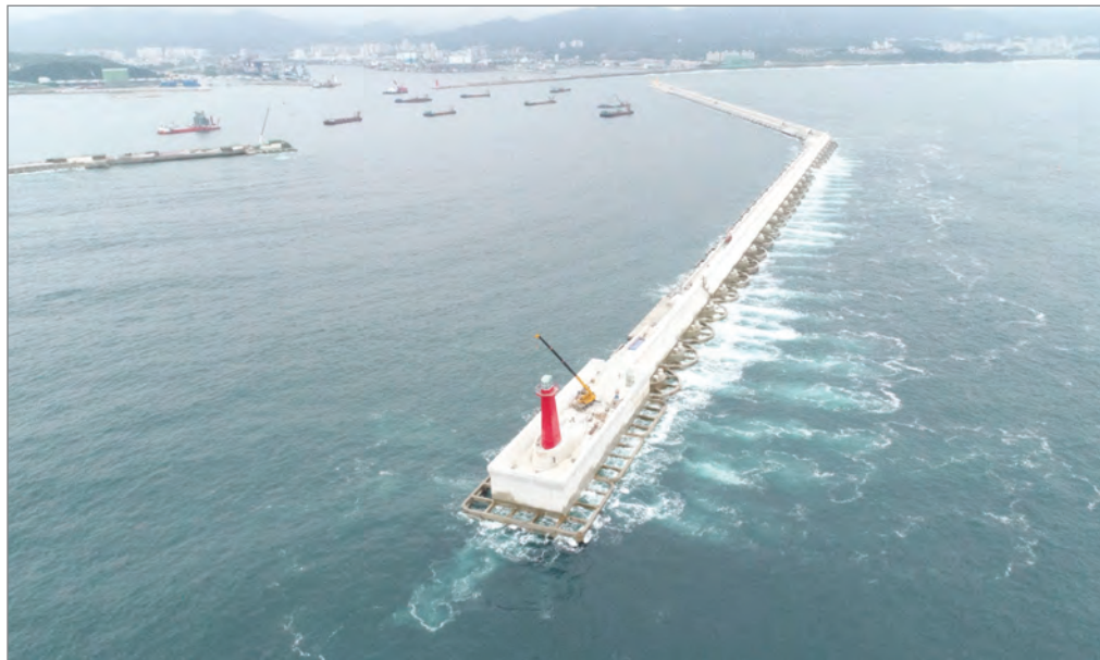
동해항 북방파제 수중공사 (2016.07~2020.02)
