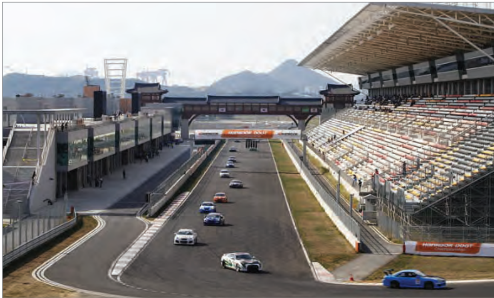
전남-영암 F1경주장 조성공사 (2008.02 ~ 2011.04)
