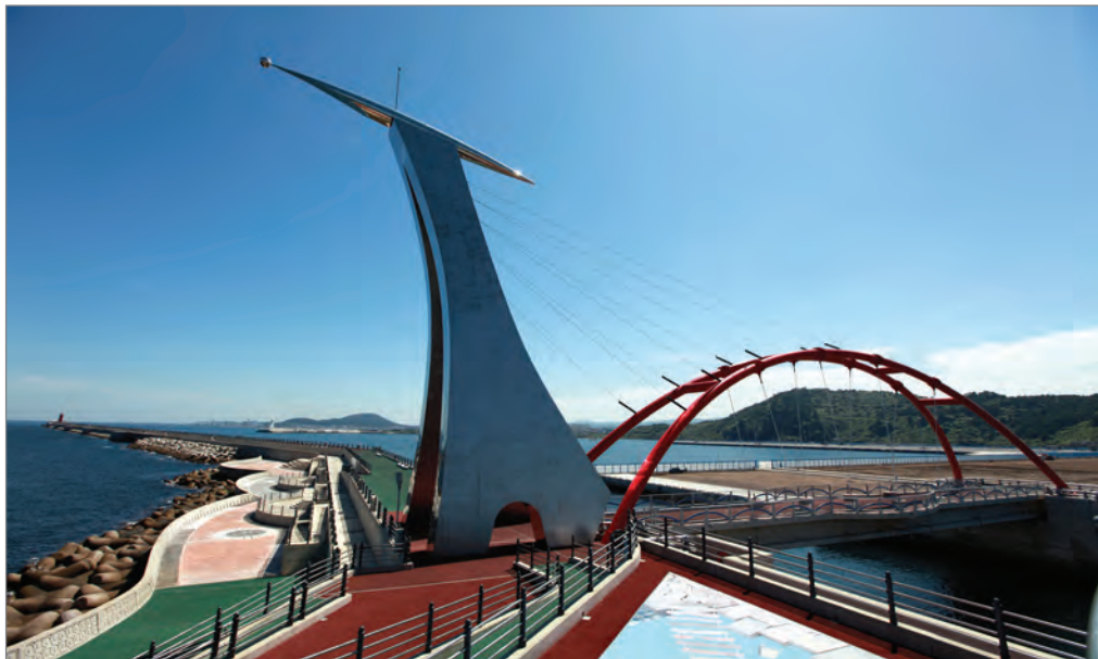
제주내항 · 외항 방파제 건설공사 (2002.07 ~ 2011.09)
