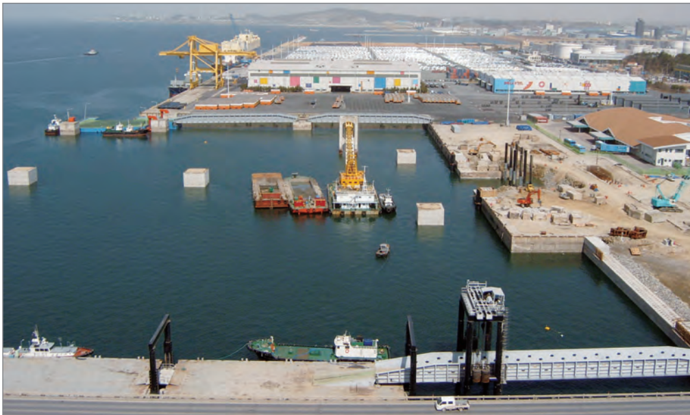
평택항 부두 조성공사 (2007.06 ~ 2011.06)
