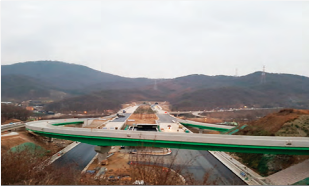
덕송~내각 고속화도로 조성공사 (2013.08~2017.04)
