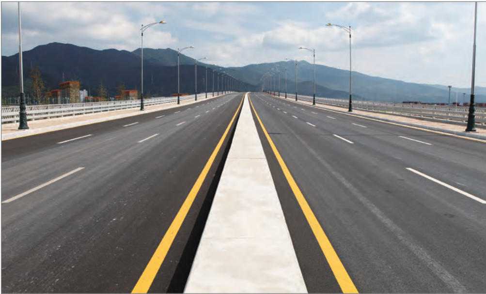
양산-물금 택지개발사업지구 교량공사 (2006.11 ~ 2009.12)
